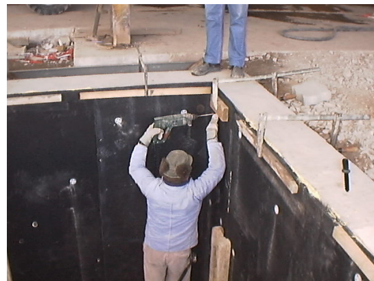
temporäre Sicherung mit Isolierstoffdübeln
